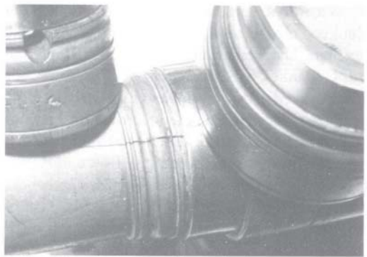
Abb. 9 Risse in der Kanzelle. Auch der stützende Mes-singring ist bereits gesprengt.
