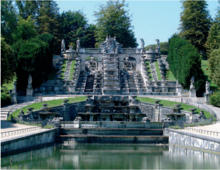
Kaskaden von Saint Cloud, 2007
